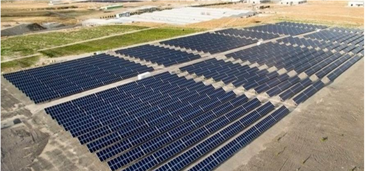
Şekil 8. Sincan ilçesi arazi üzeri 50 megawatt panel yerleşimi
