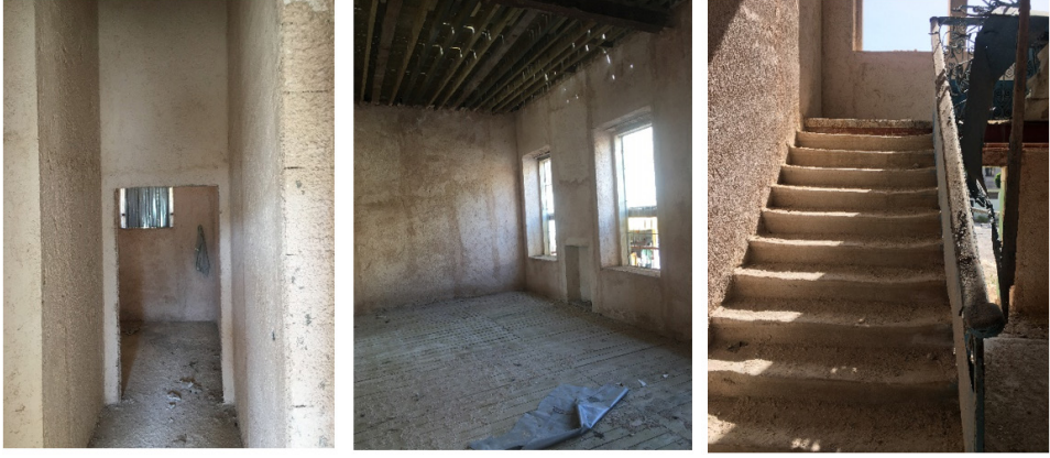
Görsel 20: Z01 ve koridor mozaik döşeme kaplaması, Z04 ahşap döşeme kaplaması ve ana katlar arası mermer basamaklı merdiven (2022)
