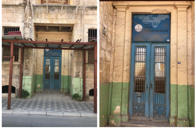
Görsel 17: Yapı ana girişi günümüz görünümü (2022)
