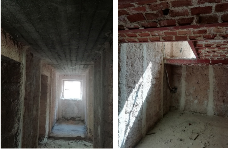
Görsel 15: Bodrum kat koridor ve merdiven açıklığı günümüz görünümü (2022)
