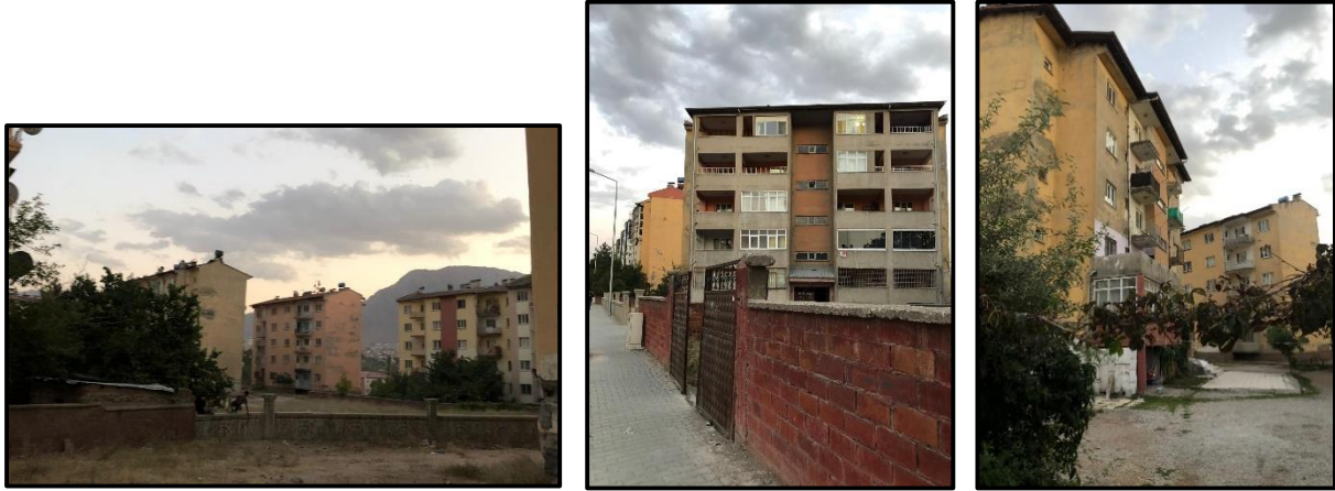
Fotoğraf 3. Kentsel Dönüşüm Projesi Kapsamındaki Konut Örnekleri (21.09.2021)
