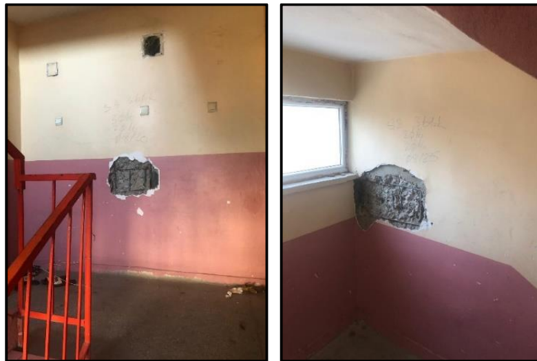
Fotoğraf 5. Müteahhit firma tarafından binalardan alınan örnekler (11.12.2021)
