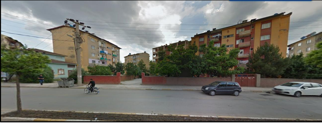
Fotoğraf 2. Kentsel Dönüşüm Projesi Kapsamındaki Konut Örnekleri [13]
