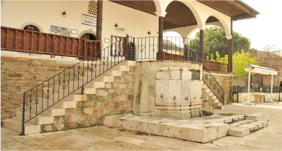
Photograph 3. Cihanoğlu Mustafâ Ağa camii Ön Cephesi ve Şadırvanı (O. Ülkü)
