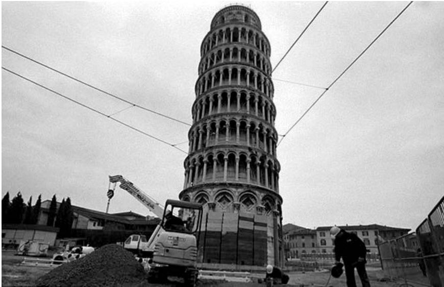
Şekil 18: Pisa kulesi çelik kablo ve kurşun külçe ağırlık uygulaması (Burland, Jamiolkowski, Squegla, & Viggiani, 2013)
