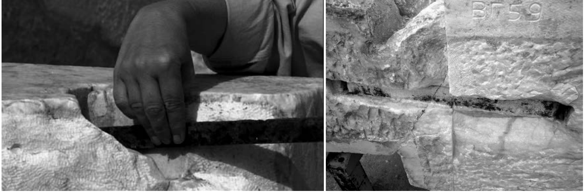
Şekil 16: Nikolaos Balanos'un akropolis restorasyonunda kullandığı demir kenet uygulaması ve atmosferik etkenlerden dolayı genişlemesi ve mermer dokuda çatlaklar oluşturması (URL-6)
