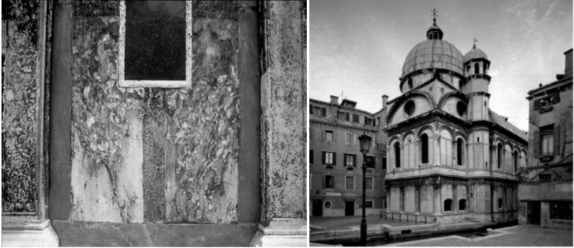
Şekil 19: Koruma işleminden önce Miracoli'nin tuz birikintileri ve yüzey kiri içeren dış görünümü (Fasinna, 1992).
