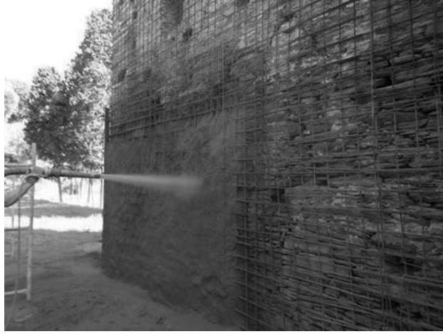
Şekil 6: Çelik hasır ile güçlendirme yöntemi (Küçükdoğan, 2007).
