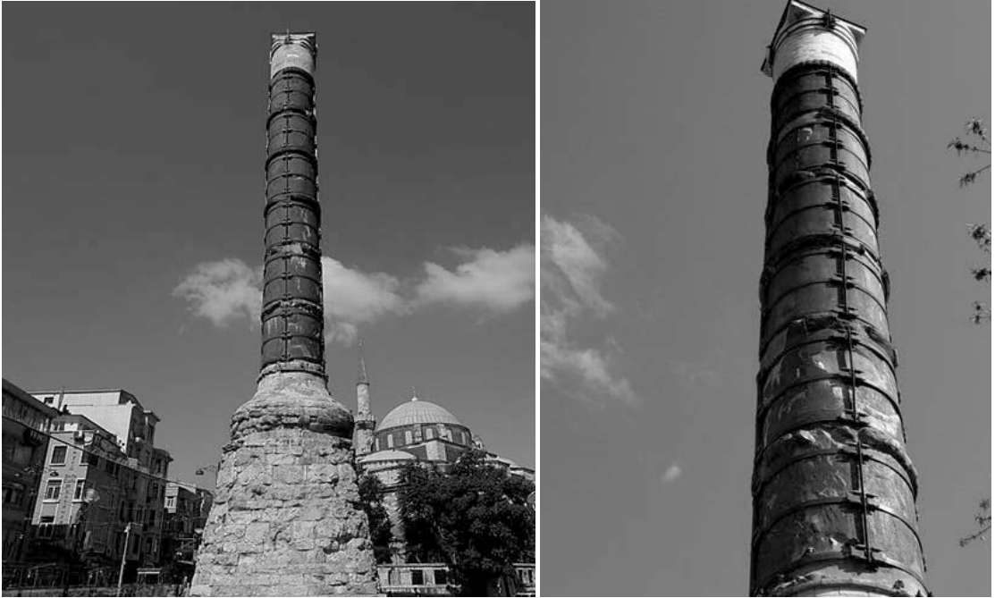
Şekil 5: Çemberlitaş çemberleme yöntemi (URL-2).
