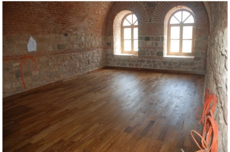
Görsel 10: Tabya ön hücre dış duvarın tamamlanma sonrası içten görünümü (sonrası).
