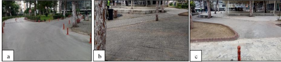
Şekil 6. (a) Beton kaplama araç yolu, (b) Kilit parke döşeme, (c) Kaldırım yüzeyi traverten döşeme
