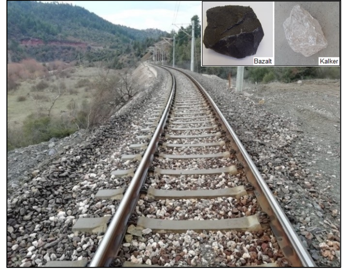
Şekil 1. Demiryolu hattında balast malzemesi olarak kullanılan bazaltın içerisinde, geçmiş yıllarda balast malzemesi olarak kullanılmış kalkerin yer alması.
