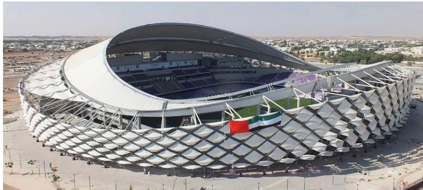
Şekil 26. Hazza Bin Zayed Stadyumu genel görünüm ("Hazza Bin Zayed Stadium, b.t.)
