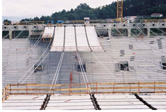
Şekil 14. Prefabrike beton panellerin yerleştirilmesi (Furtado vd., 2006)
