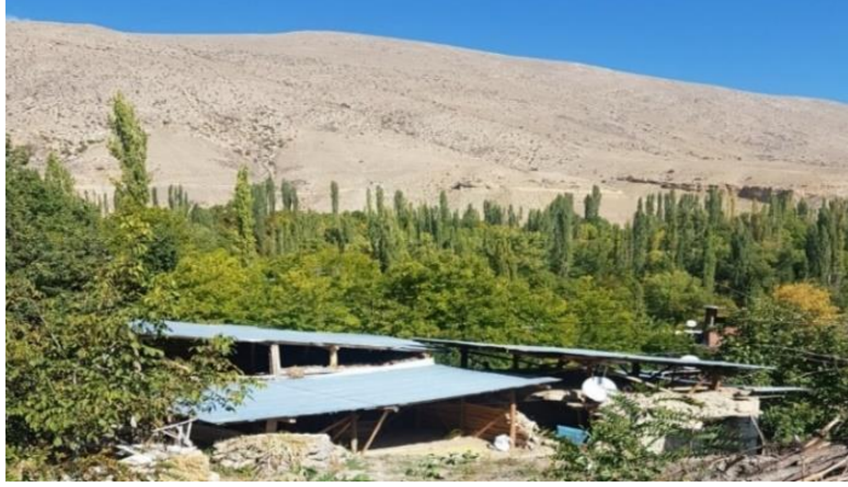
Fotoğraf 3.7. Şenyurt Mahallesi Tek Yöne Eğimli Sac Çatı Örtülerinden Görünüm
