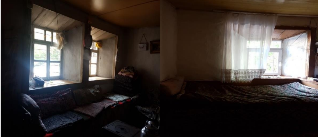
Fotoğraf 3.5. Şenyurt Mahallesi Kırsal Meskenlerinde Duvar Kalınlığından Görünümler
