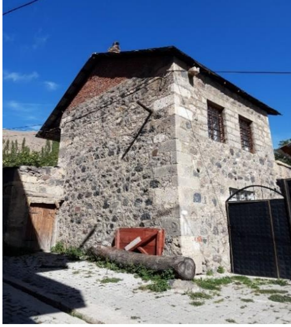
Fotoğraf 3.19. Şenyurt Mahallesinde Kesme Taştan İnşa Edilmiş Meskenden Görünüm
