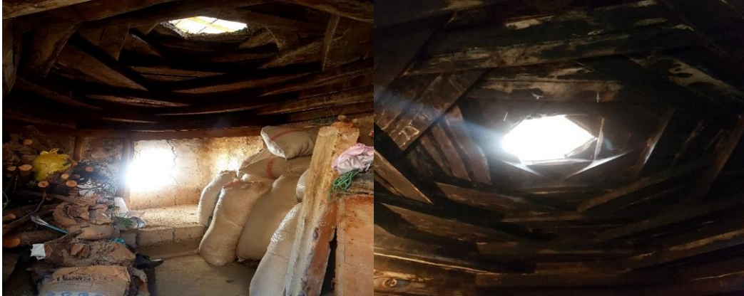
Fotoğraf 3.6. Şenyurt Mahallesi Kırlangıç Örtü Tipi Örneklerinden Görünümler
