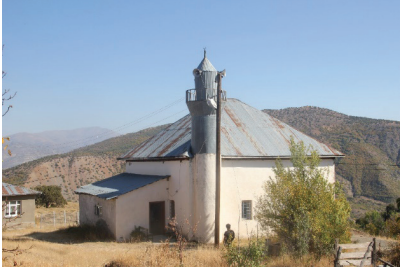
Foto 2: Batı cepheden görünüş
