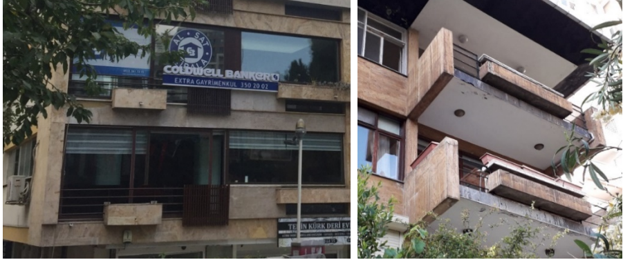
Şekil 7a ve 7b. Çizgisel ve düzlemsel korkulukların kombinasyonuna örnekler (sırasıyla); Erenköy Palas Apartmanı (Melih Koray, 1966, Erenköy) ve Seden Apartmanı (Melih Koray, 1966, Zühtüpaşa) (Kaynak: Yazarların arşivi)
