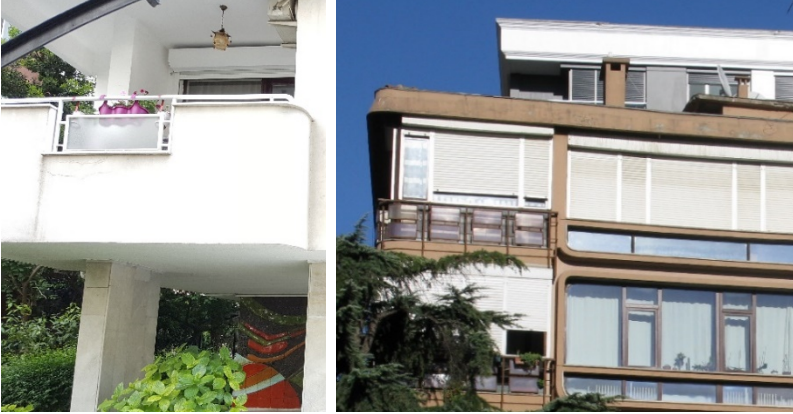
Şekil 3a ve 3b. Aplike balkon korkuluğu örnekleri (sırasıyla); Güneysu Apartmanı (Necdet Hayat, 1979, Caddebostan) ve Çifte Havuzlar Apartmanı (Demir Şamnu, 1975, Göztepe) (Kaynak: Yazarların arşivi)
