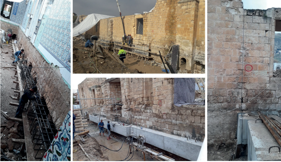
Görsel 11: Kızlar (Eyyübi) Camii, Avlusunun Güneyinde ve Kuzeyinde Yer Alan Alçak Seviyeli Duvarlarının 3'er Bloğa Ayrılarak Taşıma çalışmaları (KVMGM ve DSİ arşivi).
