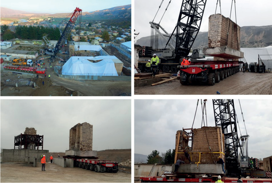
Görsel 12: Kızlar (Eyyübi) Camii, Avlusunun Güneyinde ve Kuzeyinde Yer Alan Alçak Seviyeli Duvarlarının 3'er Bloğa Ayrılması Ayrılarak 650 Ton Kaldırma Kapasiteli Mobil Vinçle Yerlerinden Kaldırılma ve Taşıma Çalışmaları (KVMGM ve DSİ arşivi).
