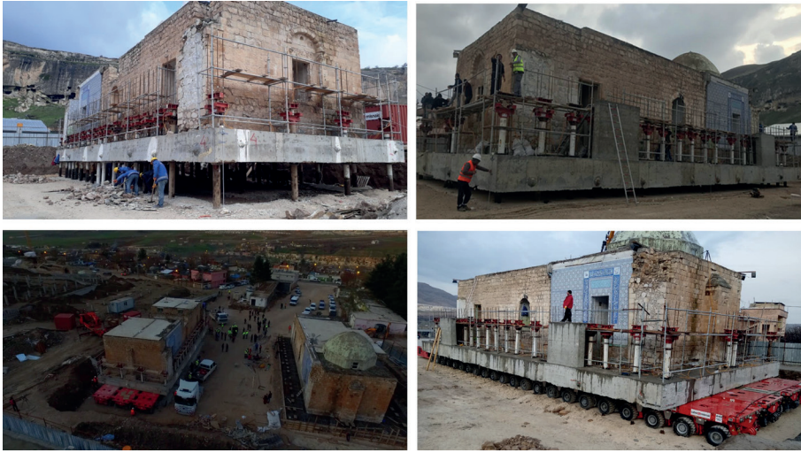
Görsel 17: Kızlar (Eyyubi) Camii Batı ve Doğu Bloğu Strüktürel Bütüncül Taşıma Projesi Kaldırma Kriko Sistemiyle Kaldırılması ve SPTM taşıyıcı platform üzerine Alınması (KVMGM ve DSİ arşivi).
