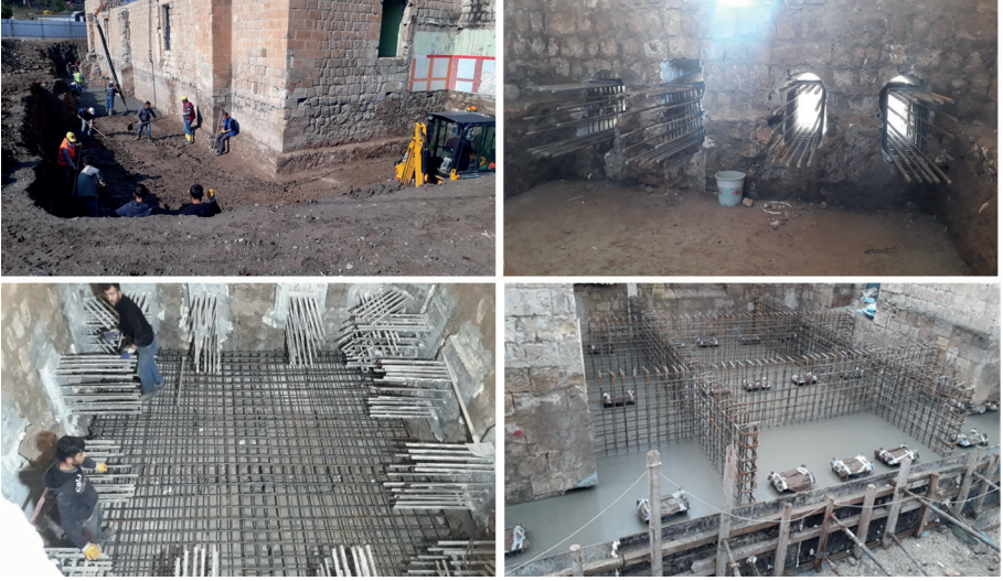
Görsel 14: Kızlar (Eyyubi) Camii Batı Bloğu Strüktürel Bütüncül Taşıma Projesi Betonarme Temel Zemini Platformu ve Betonarme Kaldırma Platformu İmalat Çalışmaları (KVMGM ve DSİ arşivi).
