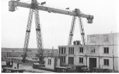
Resim 6: Prefabrik Konutların yapımından bir resim (Kaufmann, 2014).
