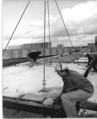
Resim 5: Prefabrik Konutların yapımından esnasında hazır döşemenin konulması (Bundesarchiv, 1970).
