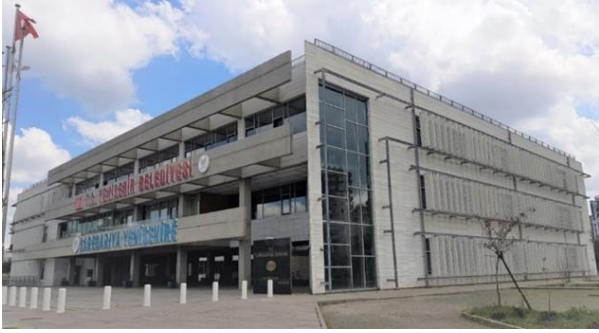
Şekil 2. Yenişehir Belediyesi Hizmet Binasının kuzeybatıdan görünüşü
