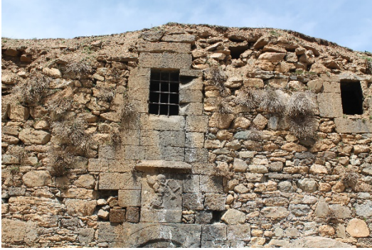
Şekil 21: Güney dış çephe pencereleri
