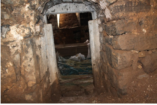
Şekil 29: Kapı iç mekandan görünümü
