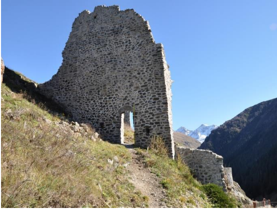
Res. 56. Kuzey Cephesi Dış Tarafı
