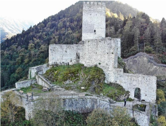
Res. 7. Zir Kale Kuzeydoğu Cephe
