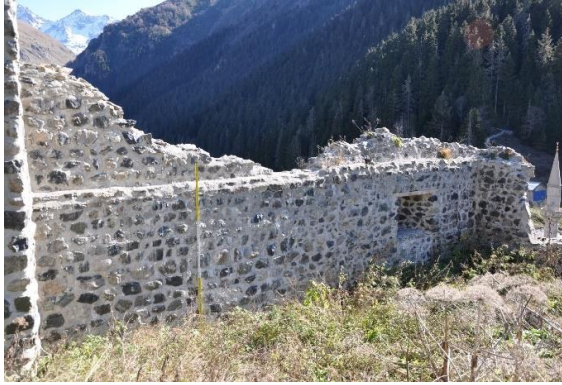
Res. 47. Güney Sur Duvarı
