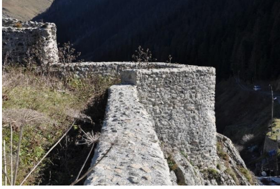
Res. 53. Batı Sur Duvarı ve Burçları
