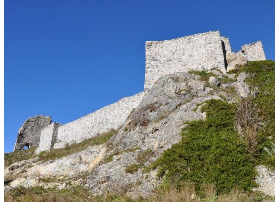
Res. 52. Batı Sur Duvarı ve Burçları
