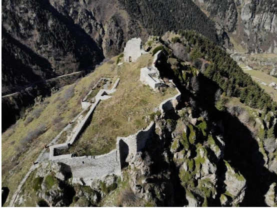
Res. 45. Kale-i Bala Güney Cephe
