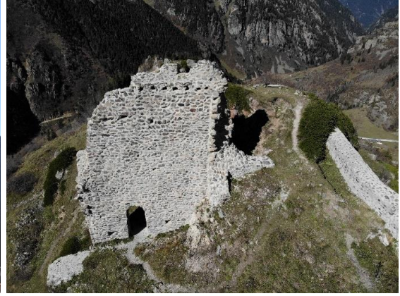
Res. 57. Kuzey Cephesi İç Tarafı
