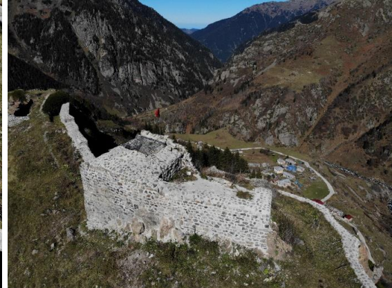
Res. 62. Sarnıç Yapısı Batı Tarafı
