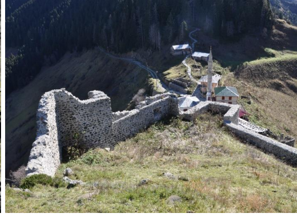
Res. 46. Kale-i Bala Güney Sur Duvarı
