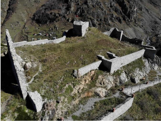
Res. 51. Kuzeybatı Cephe
