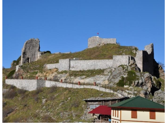
Res. 50. Batı Sur Duvarı
