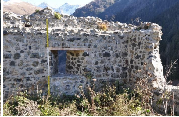
Res. 48. Güney Sur Duvarındaki Pencere
