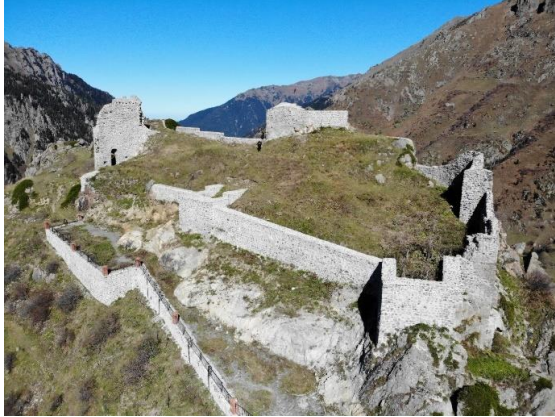
Res. 49. Güneybatı Cephe
