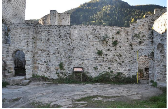
Res. 18. Mekanlara Giriş Kapıları
