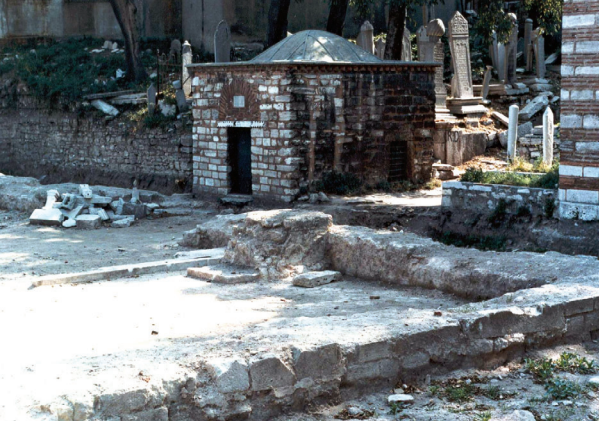
3. Şeyh Vefa Camii'nin Tekrar İnşa Edilmesinden Önceki Durumu.
