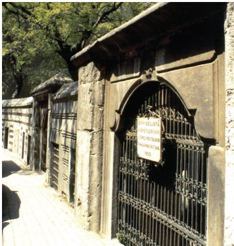
20. Şeyh Vefa Külliyesi İhata Duvarı ve Hacet Pencerceleri.
