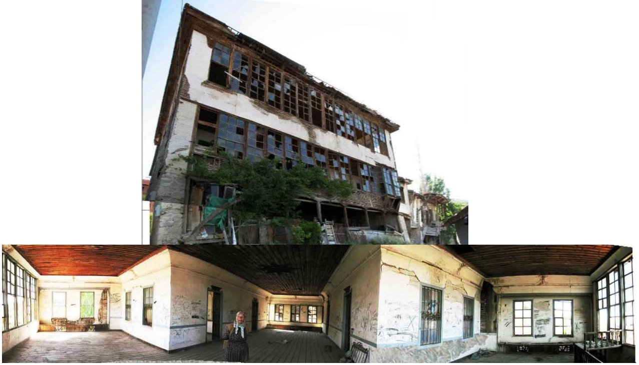
Şekil 10. İğdecik Köyü Bey Konağı
