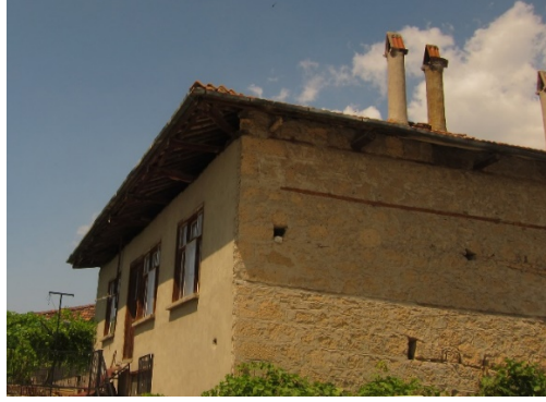
Şekil 4. Gönen’de Yığma Yapım Sistemi
