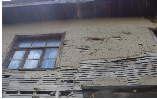
Şekil 3. Gönen'de Bağdadi Yapım Sistemi (Er Akan, 2004, s.46)
