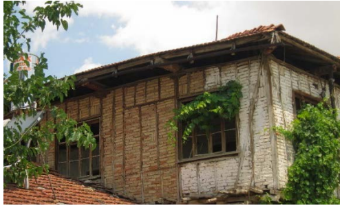
Şekil 2. Tuğla Dolgulu Hımiş Yapı, Gönen
