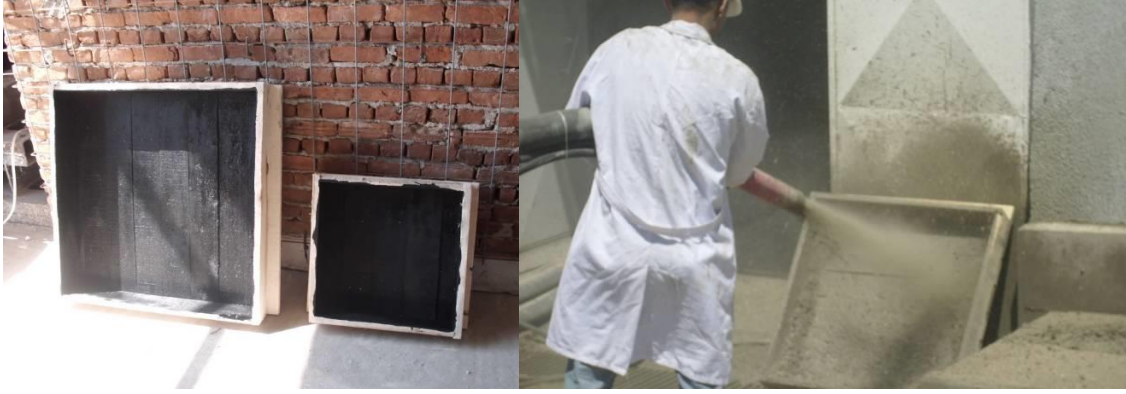
Şekil 2. Püskürtme Beton Panelleri ve Panellere Kuru Karışım Püskürtme Betonun Uygulanması
