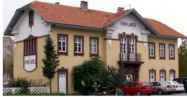
Resim 2. Kırklareli Gar Binası Giriş Cephesi
