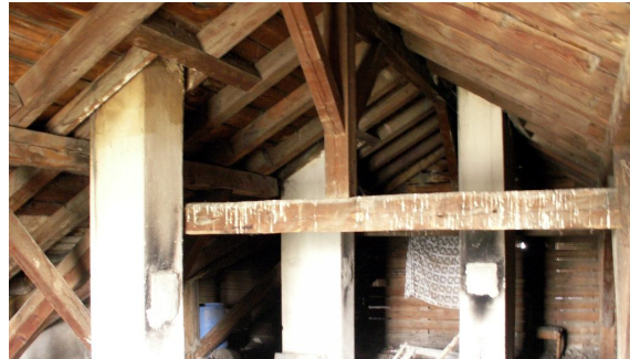
Resim 14. Kırklareli Gar Binası Ahşap Çatı Makası
