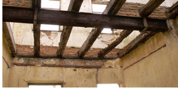
Resim 12. Taşağıl Yolcu Binası Birinci Kat Döşemesi
