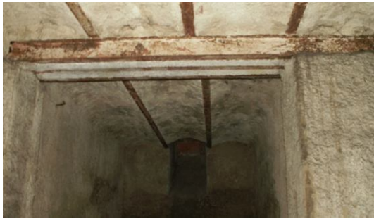
Resim 7. Babaeski Gar Binası Bodrum Kat Döşemesi
