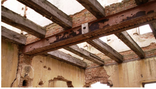
Resim 11. Kavaklı Yolcu Binası Birinci Kat Döşemesi
