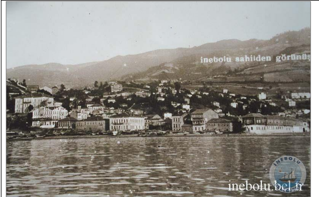
Resim 12. İnebolu sahilinde soldan sağa doğru Eski Hükümet Konağı, Türk Ocağı Binası, Kayıkçılar Kahvesi, Gümrük Müdürlüğü Binası, Osmanlı Bankası ile Telgraf ve Posta Binası (1920'li yıllar) (M. Fakazlı Arşivi)
