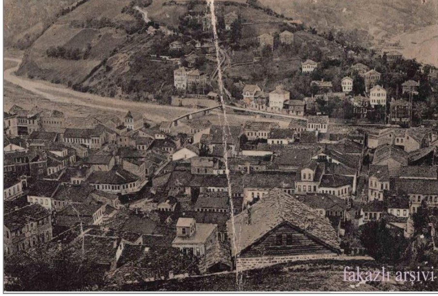
Resim 8. Ahşap köprü genel görünüş (20. yüzyılın başı)
