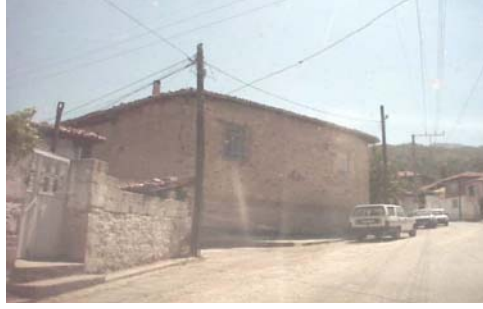
Şekil 1. Tipik bir yığma yapı [1]
