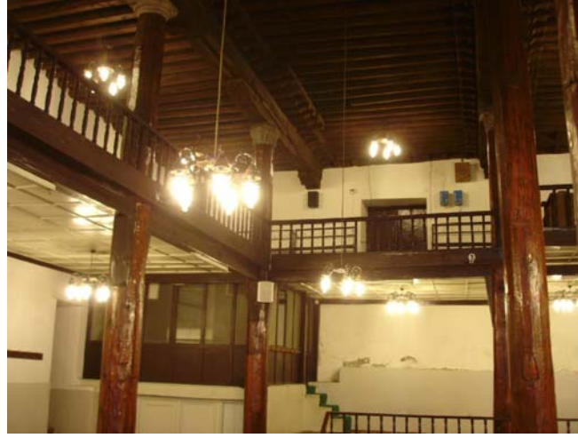
Şekil 2: Ahi Elvan Camisi'nin Ahşap Taşıyıcı Sistemi
