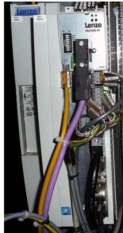
Şekil 4. Lenze 9300 Inverter
