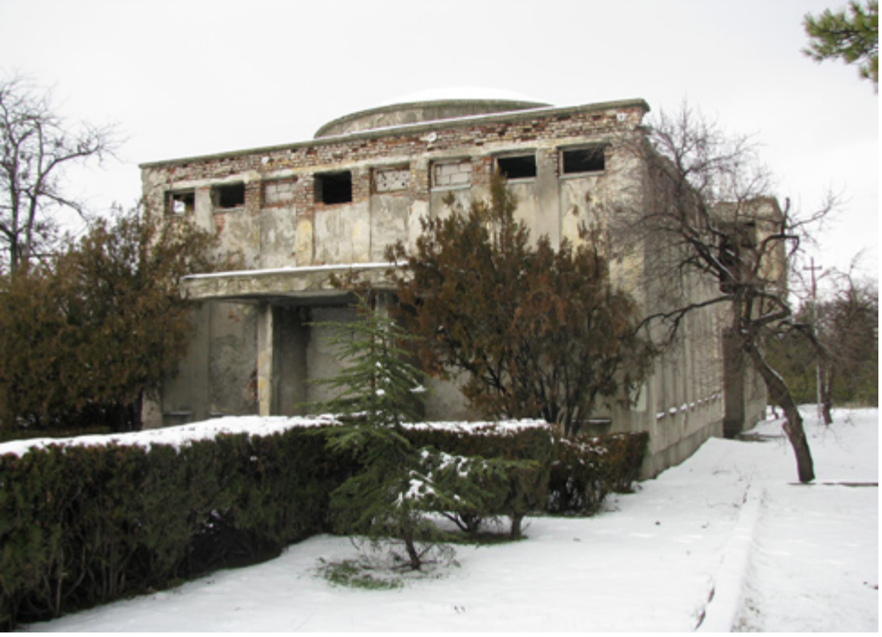
14. Bira Fabrikası Hamamı, Güney Cephe
