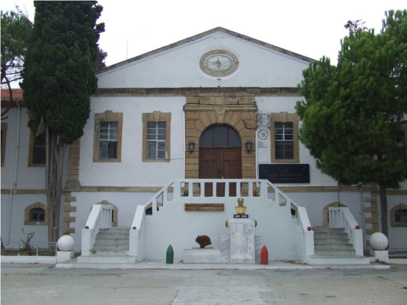
Resim 8. Değirmenburnu Tabyası Kışla Binası
