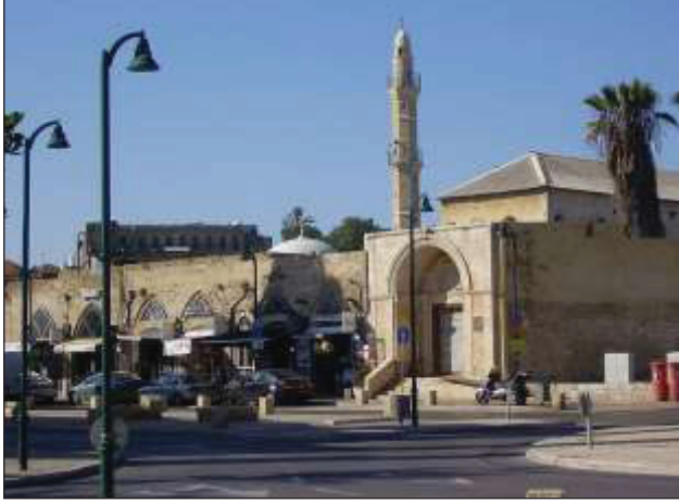
Şekil 8. Yafa Kışla Binasının otel yapılmadan önceki hâli (Geniş kemerli kapının ardındaki kırma çatılı bina).
