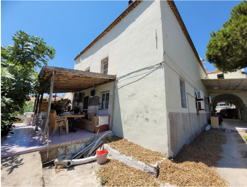
Fot 8. Doğu Cephesi
