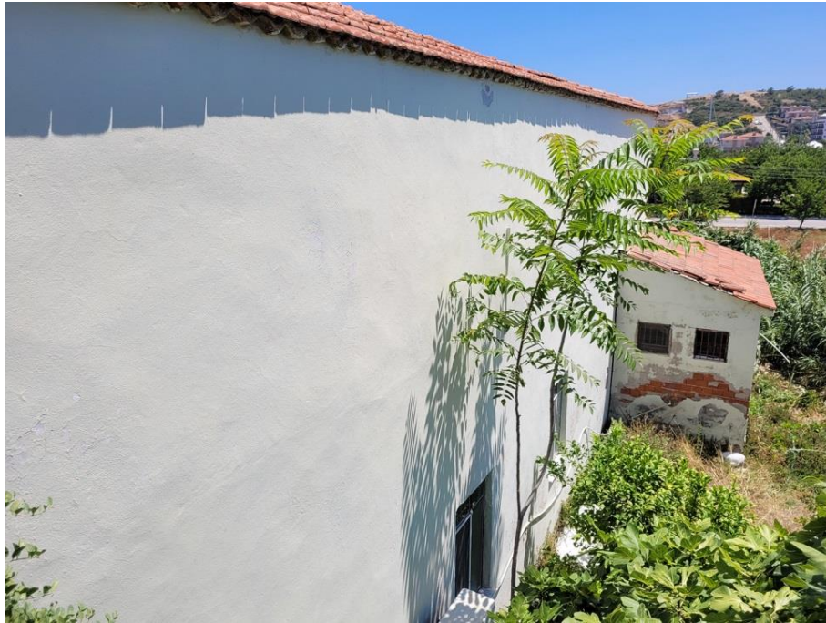
Fot 6. Güney Cephesi
