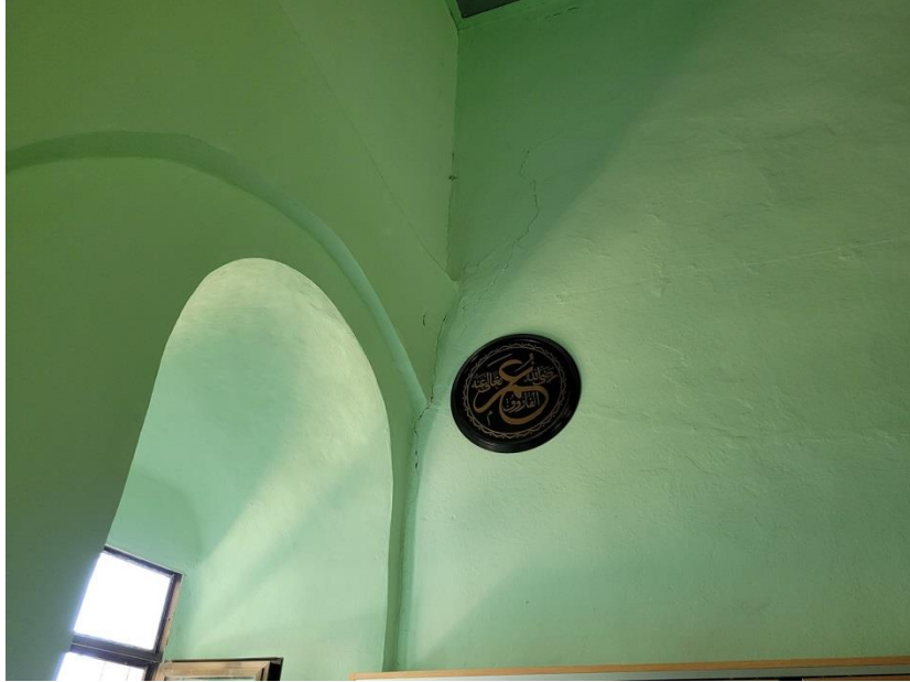
Fot 12. Kuzey ve doğu duvarlarının kesişiminde yer alan tonoz izi
