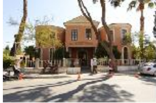
Fotoğraf 36. Milas Hükümet Konağı Güney Cephe
