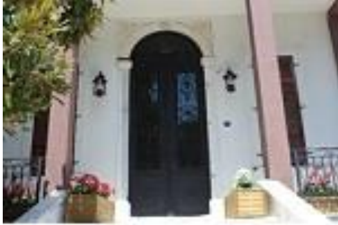
Fotoğraf 24. Kemalpaşa (Nif) Hükümet Konağı Giriş Kapısı
