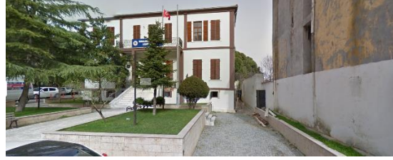
Fotoğraf 29. Kemalpaşa (Nif) Hükümet Konağı Güney Cephe 2
