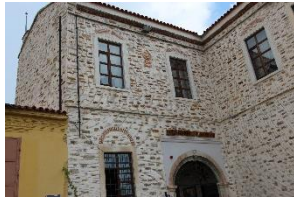
Fotoğraf 16. Bayındır Hükümet Eski Konağı Güney Cephe Batı Kısım
