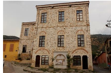
Fotoğraf 15. Bayındır Hükümet Eski Konağı Güney Cephe Doğu Kısım
