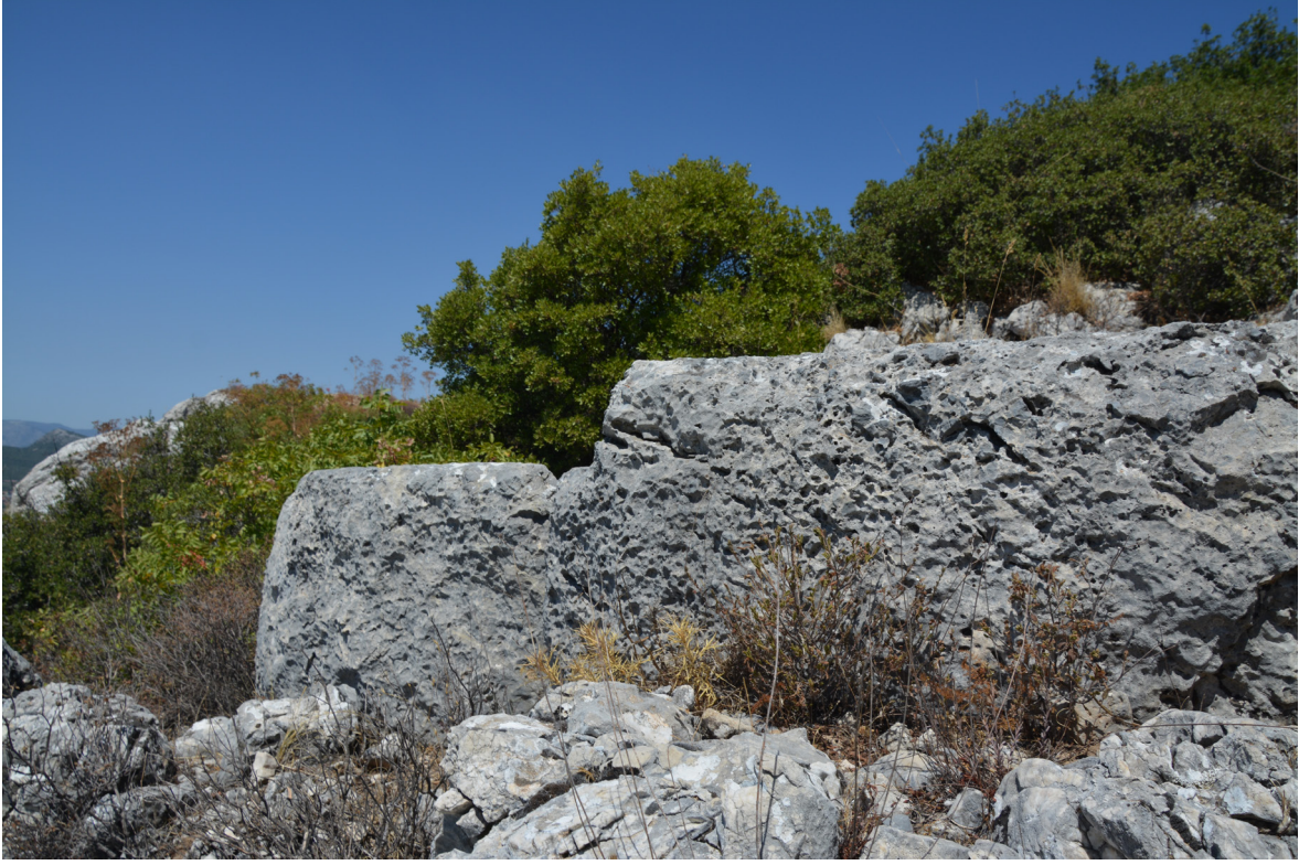
Fig. 23. Güney surlarının kesmetaş bloklarının kenarlarında açılan kademelendirilmiş oturma yüzeyleri
