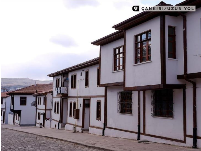
Şekil 7: Geleneksel Çankırı Evlerinin Cephe Görünüşü
