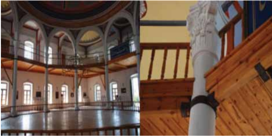
Resim 14-a ve 14-b: Solda Sema mahallinden üst kat mahfillerine bakış ve sağda üst kat mahfilinin metal kelepçeler ile kornet başlıklı sütunlara bağlanma detayı görülmektedir (Fotoğraf yazar tarafından belgelenmiştir).
