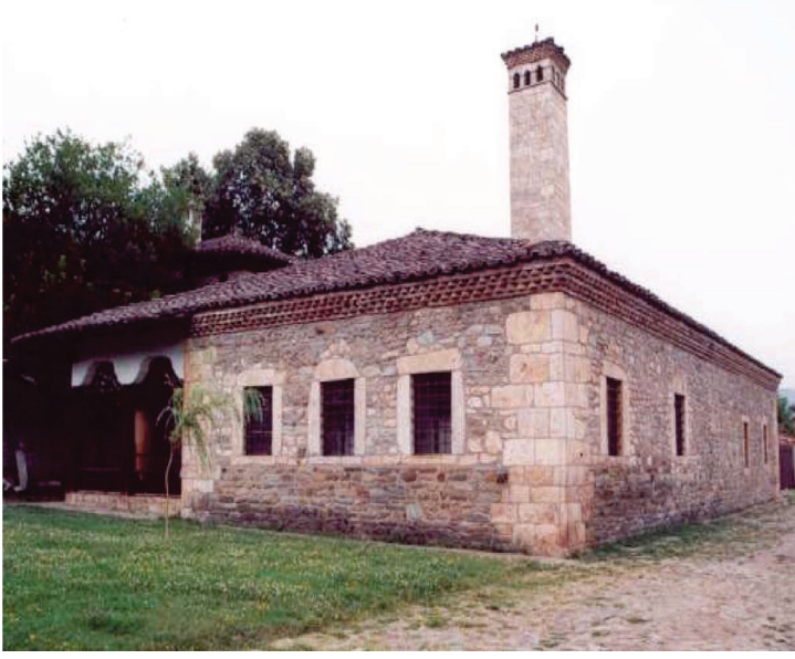
Resim 2: Mescit binasının güneydoğu cephesi (Mediu-Dushi, 2010: 43)
