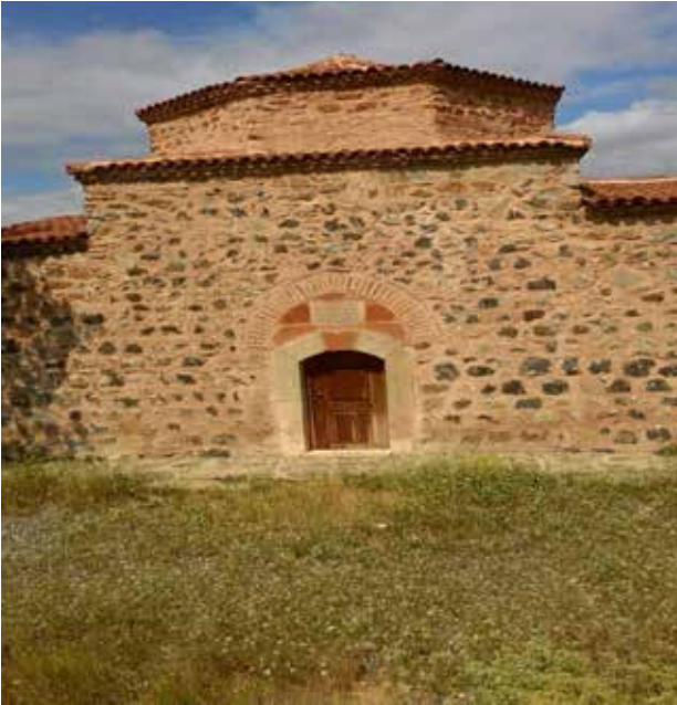
Fotoğraf 2. Çöreğibüyük Türbesi Doğu Cephesi
