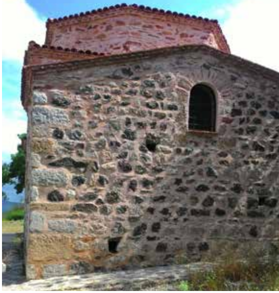
Fotoğraf 3. Çöreğibüyük Türbesi Güney Cephesi
