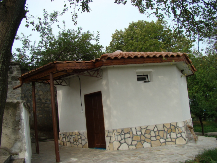
31: Hasan-Hüseyin Türbesi, güney cephe
