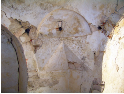
Fotoğraf: 9) Geçiş sistemi ve künkler
