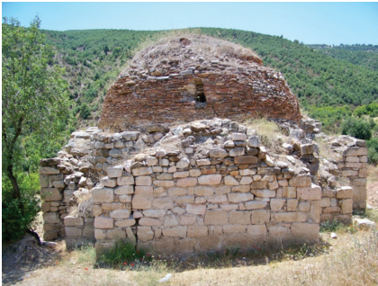
Fotoğraf: 5) Kuzey cephe
