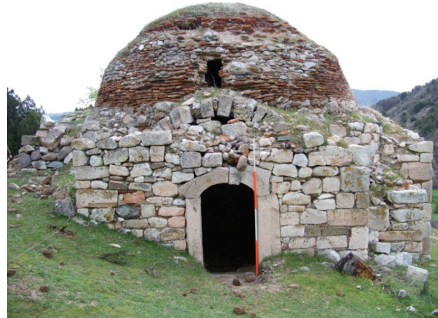
Fotoğraf: 6) Batı cephe
