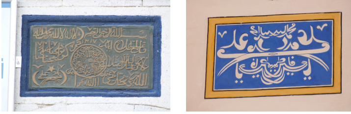
Foto. 10-11: Trabzon Arsin Atayurt Mahallesi Merkez Camii giriş kapısı ve harim duvarındaki Zülfikarlar
