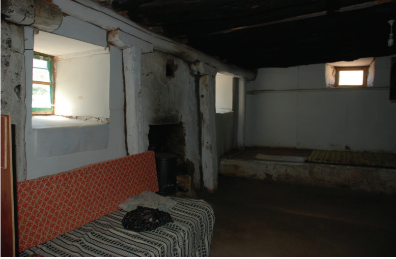
Fotoğraf 2: Tavan örtüsünü taşıyan ahşap sütunlar
