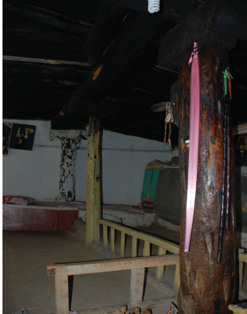
Fotoğraf 3: Tavan örtüsünü taşıyan ahşap sütunlar
