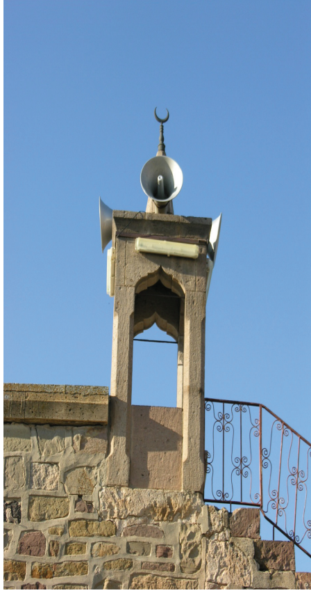
Fotoğraf 29:- Cuma Camii. Köşk (merdiven, minber) minare.
