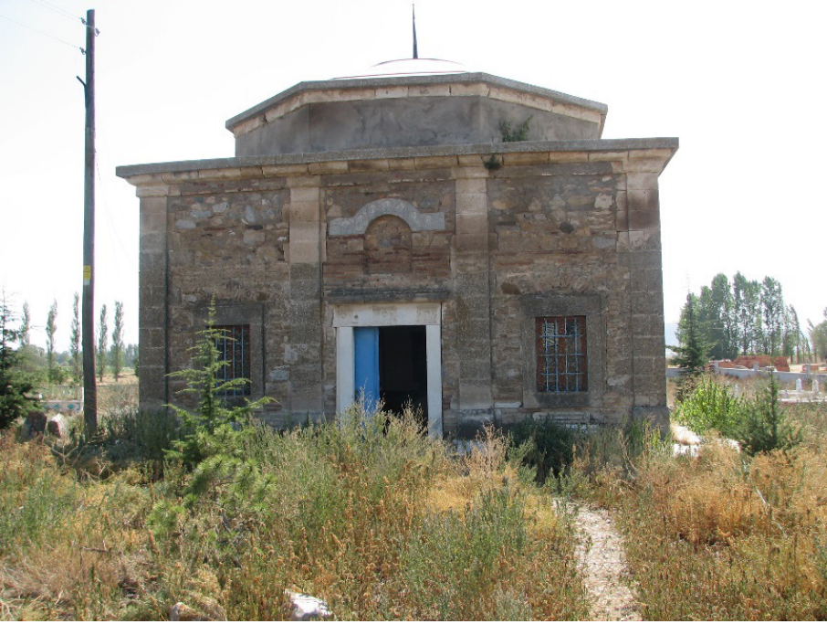
Fotoğraf 3. Seydisül Türbesi. Kuzey Cephe.
