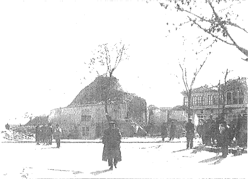
Resim 6. Türbe Hamamı, yıkılmadan önce
