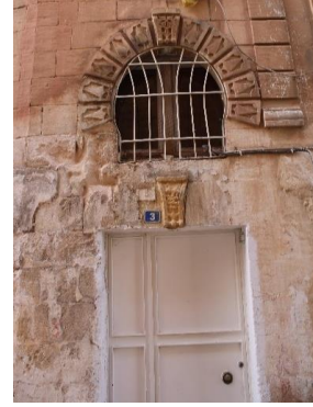
Fotoğraf 9: Şar Mahallesi
