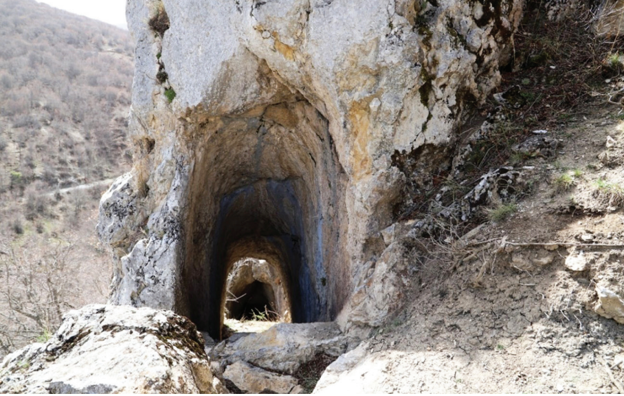
Resim 6: Dereköy Kalesi Basamaklı Tüneli (Dıştan Görünüm)
