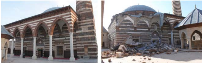
Şekil 3. Van Hüsrev Paşa Cami'nin 2011 Van depremi öncesi ve sonrası görüntüleri [30] (Images of Van Hüsrev Pasha Mosque before and after the 2011 Van earthquake)
