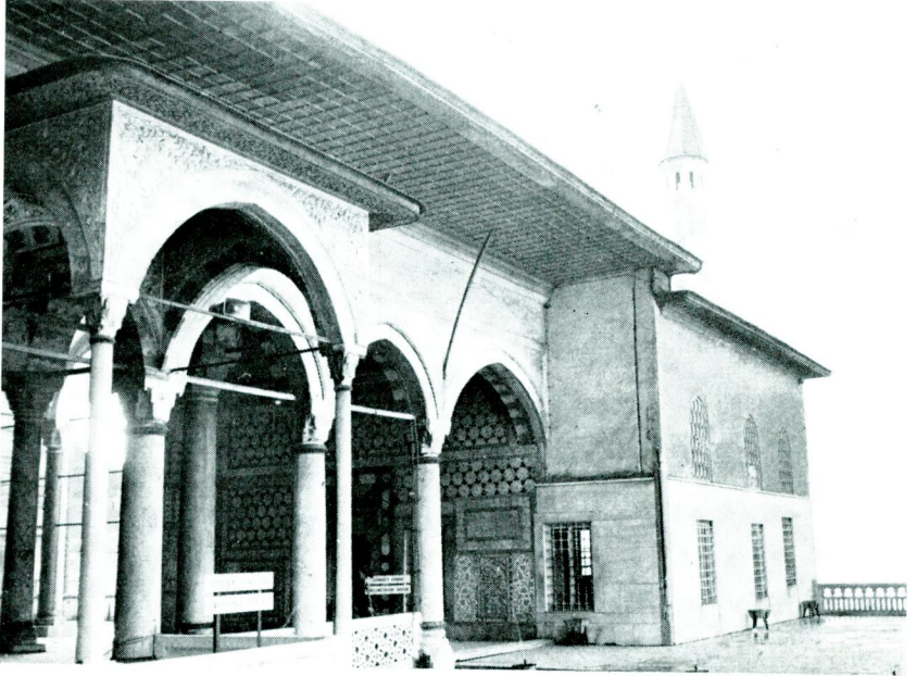
Res. 13 — Topkapı sarayında Sultan İbrahim tarafından yapılan Sünet Odası
