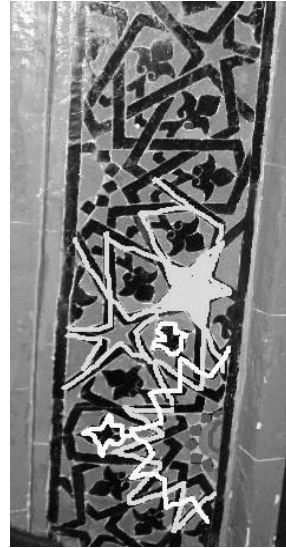
Fot.8. Dış Bordür Yerleşimi
