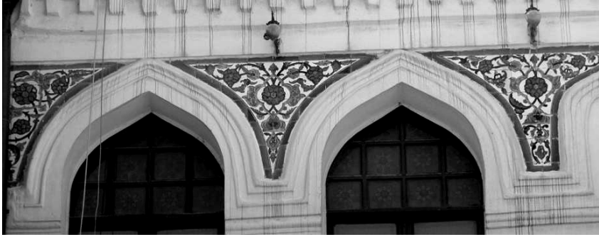
Fotoğraf: 13 Konya Postane Binası Orta Bölüm Üst Kat
