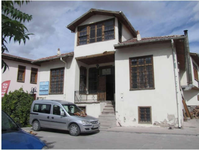
Resim 11: Eski Selçuklu Araştırmaları Merkezi Cihannüma Görünüş
