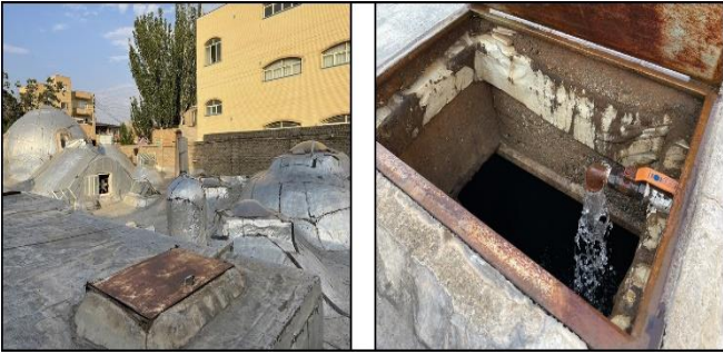
Şekil 4. Nezafet hamamının su depoları (Şekil yazara aittir)
